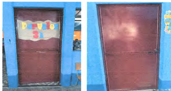
Foto 2: MANTENIMIENTO A ESTRUCTURA, LIJADO, CEPILLADO APLICACIÓN DE PINTURA, E CAMBIO DE CHAPA
