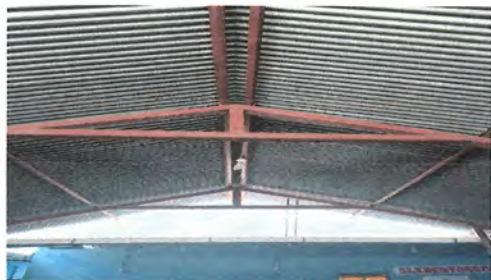
Foto 1: MANTENIMIENTO DE ESTRUCTURA DE SOPORTE DE METAL EN PATIO, LIJADO, CEPILLADO, APLICACIÓN DE PINTURA
