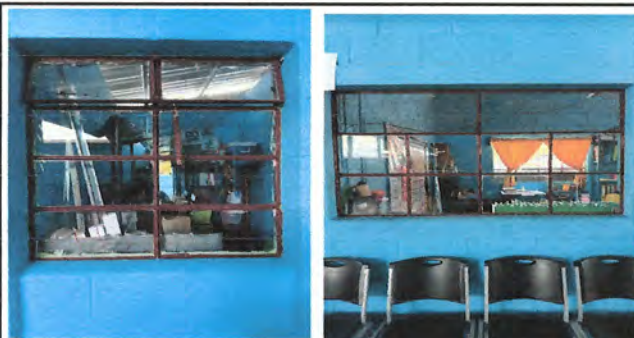
Foto 3: SUSTITUCION DE ESTRUCTURA DE METAL DE VENTA POR VENTANA CORREDIZA PVC
