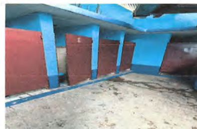
Foto 4: MANTENIMIENTO A ESTRUCTURA, LIJADO CEPILLADO, APLICACIÓN DE PINTURA
