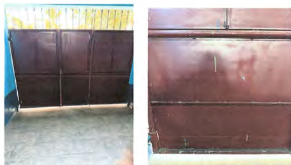
Foto 3: MANTENIMIENTO A ESTRUCTURA, LIJADO, CEPILLADO, APLICACION DE PINTURA A PORTON
