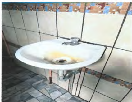
Foto 1: SUSTITUCION DE LAVAMANOS Y SUS ACCESORIOS
