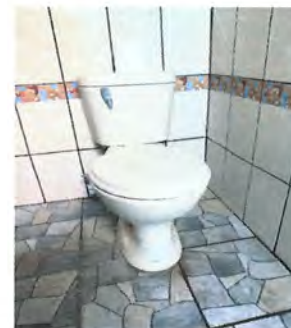
Foto 2: SUSTITUCION DE SANITARIO
