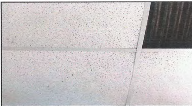
Foto 4: Sustrución de Cielo Falso en aula
