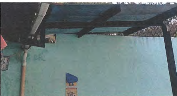
Foto 9: Sustrucción de lámina, por lámina troquelada aluzinc calibre 26, en galera del patio del nivel preprimario
