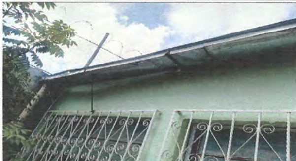
Foto 8. Sustrucción de bajadas de agua pluvial.
