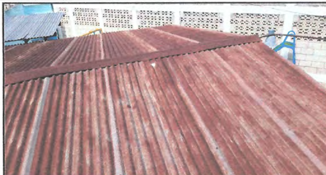
Foto 1: Sustrución de lámina, por lámina troquelada aluzinc calibre 26 de 12 pies, en aula
