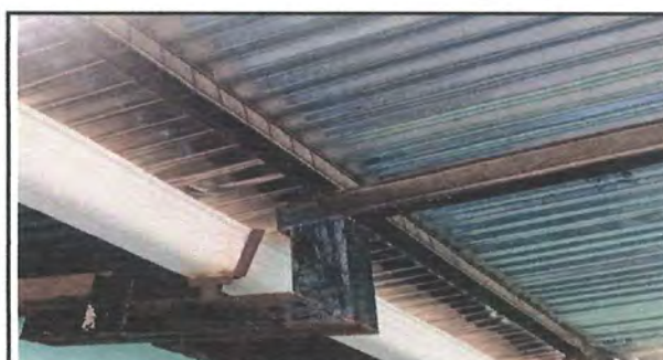
Foto 10: Sustrucción de estructura de soporte de metal, por metal, en galera del patio del nivel preprimario
