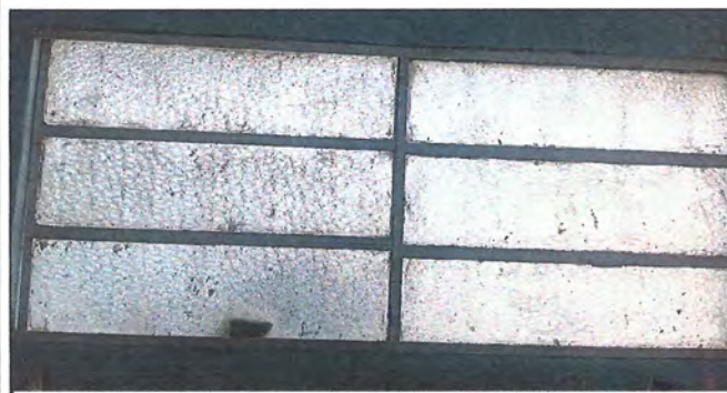
Foto 5: Sustrución de ventanas de metal por ventanas de pvc, en aula
