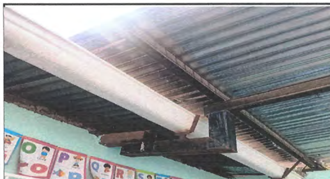
Foto 3: Sustrución de canal en pvc, por metal, y pescantes
