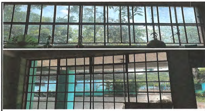
Foto 4: Mantenimiento a balcones de metal
