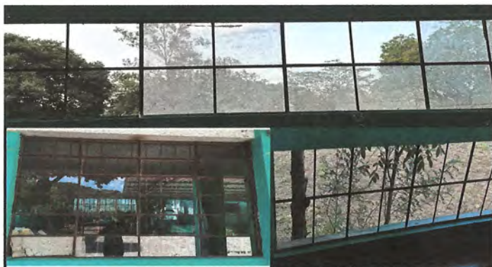
Foto 3: Sustitución de estructura de metal de ventana, por ventana corrediza de PVC
