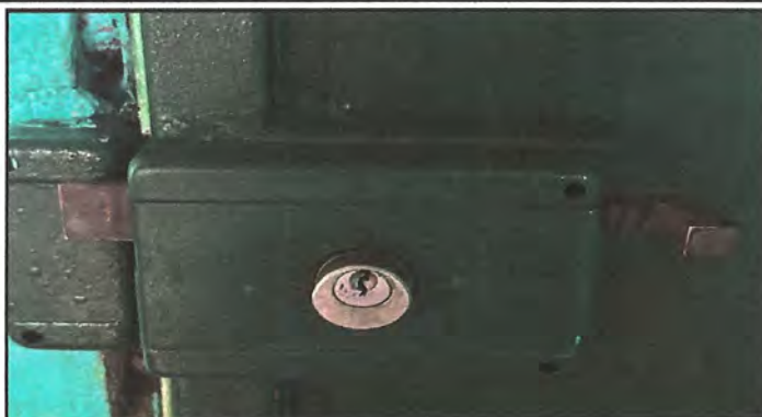
Foto 2: Sustitución de chapa
