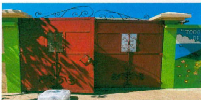
Foto 3: Mantenimiento a porton de metal principal
