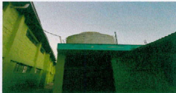
Foto 4: Sustitucion de deposito de agua de 1100 lt
