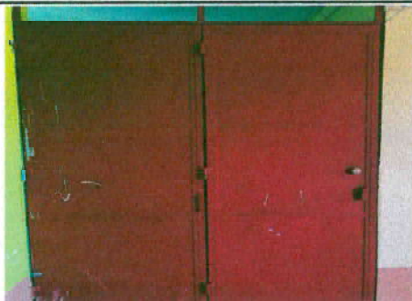
Foto1: Mantenimiento a puertas de aulas y direccion
