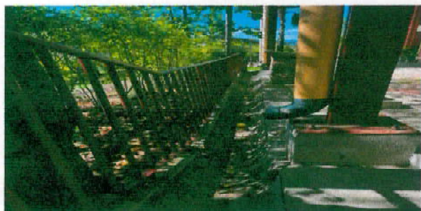
Foto 5: Reparacion de bajada de agua Pluvial, tuvo PVC 3"
