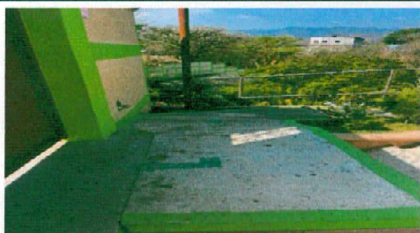
Foto 5: Fabricacion e instalacion de baranda de metal en rampa de acceso
