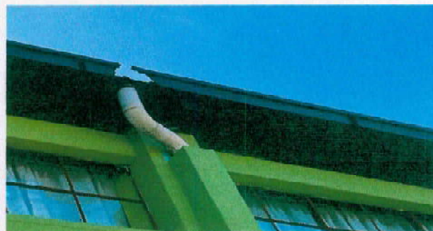
Foto 4: Sustitucion de canal de metal
