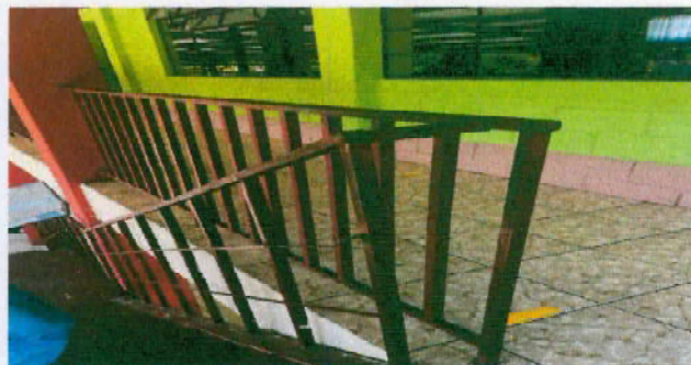
Foto 2: Mantenimiento a a baranda de metal del segundo nivel
