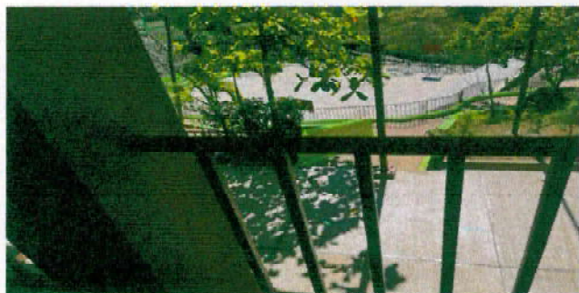
Foto 1: Mantenimiento a a baranda de metal del segundo nivel
