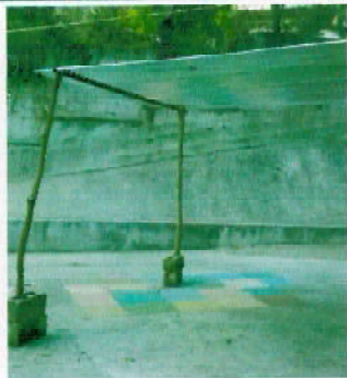
Foto1: galera con estructura de madera, ubicada en el patio la cual se reemplazara por galera de metal y lamina
