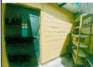
Foto 2: estructura de metal y lamina utilizada como aula la cual se elebara 40 centimetros.
