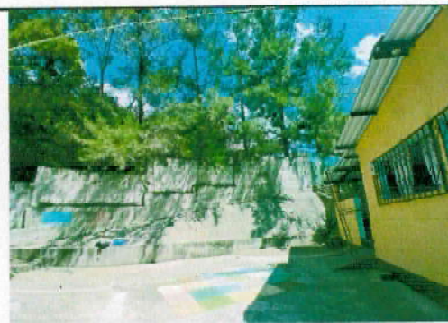
Foto 6: muro perimetral de la escuela en el que se solocara el razor ribbon.
