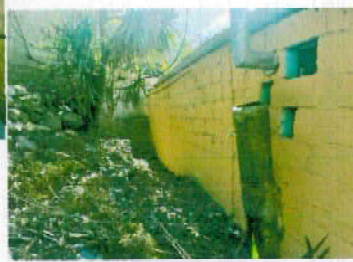
Foto 4: Bodega de la escuela en donde se realizaran ventanas y colocaran balcones.
