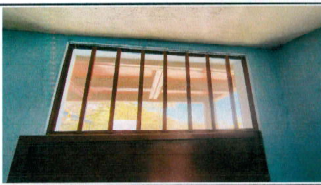
Foto 5: Según región 2.1 Intalacion de malla en sobre marcos de puerta
