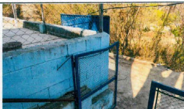
Foto 6: Según región 7.1 Reconstrucción de porton entrada principal
