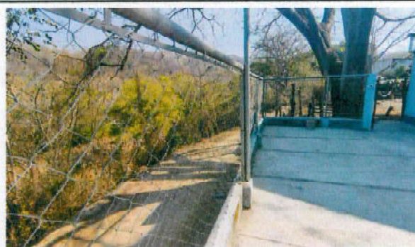
Foto 4: Según región 5.2 Tensión de malla perimetral
