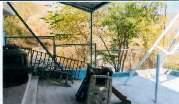
Foto 2: Según región 9.1 instalación de Pila de concreto de dos labaderos (incluye instalación de drenajes)
