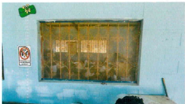
Foto 1: según Región 1.1 Instalacion de Ventana pvc
