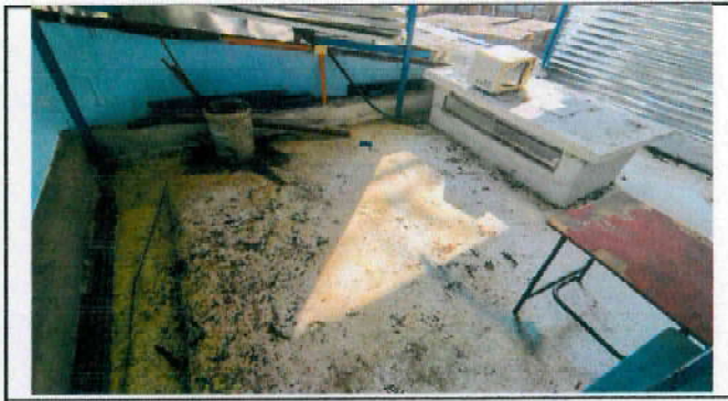
Foto 6: Según región 3.1 Raparacion de pañuelos (aplicación de mezccon, incluye impermeabilizante)
