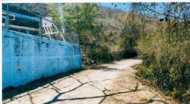
Foto 5: Según región 6.1 Pintura de parte exterior y muro perimetral
