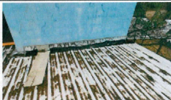
Foto 2: Según región 4.2 Canal interno de aula fabricado de lamina gruesa
