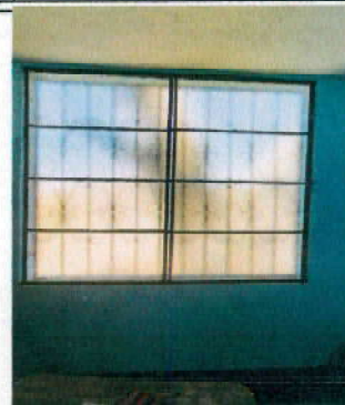
Foto 2: Según región 1.2 Sustitucio de ventanas de metal a pvc
