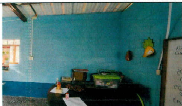
Foto 3: Según región 1.3 instalacion de ventana de pvc (incluye apertura, tallado y balcon)
