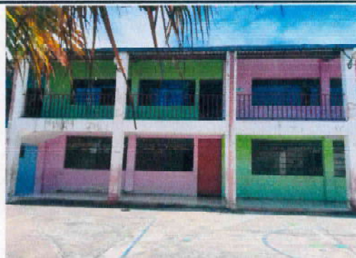
FOTO 8: APLICACIÓN DE PINTURA EN MUROS EXTERIORES
