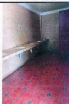
FOTO 6: SUSTITUCIÓN DE GRIFOS EN LAVAMANOS
