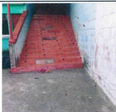
FOTO 3: SUSTITUCIÓN DE PISO CERÁMICO EN GRADAS
