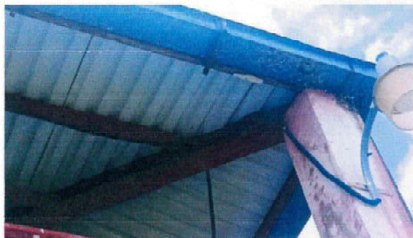
FOTO 7: SUSTITUCIÓN DE CANAL DE METAL
