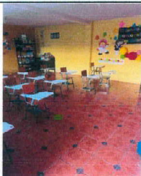
FOTO 1: SUSTITUCIÓN DE PISO CERÁMICO EN AULAS
