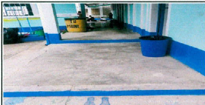
Foto 7: Sustitución de piso de torta de concreto por piso de granito en corredor y aulas de primero a sexto módulo 1
