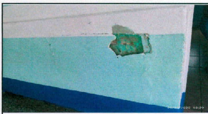
foto 10: sustitucion de repello en pared de aula de computación, módulo 2
