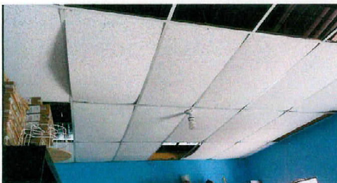
Foto 9: Sustitución de Cielo Falso en dirección, módulo dos
