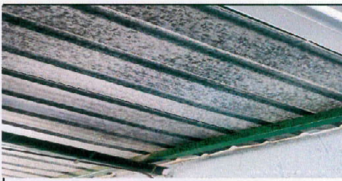
foto 12 : Sustitución de estructura de aula de primero y segundo en módulo 1
