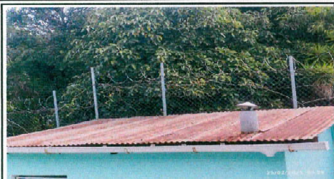
Foto1: Sustitución de lámina en cocina, por lámina troquelada aluzinc calibre 26 de 12 pies
