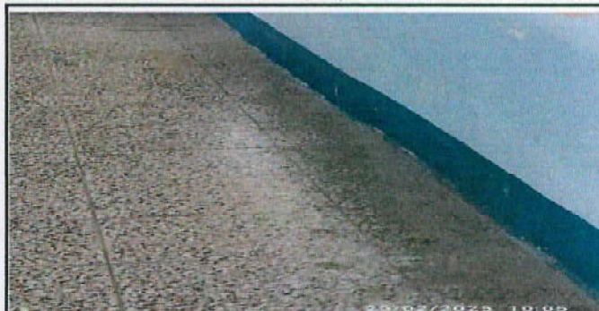
Foto 8: mantenimiento de piso granito en módulo 2
