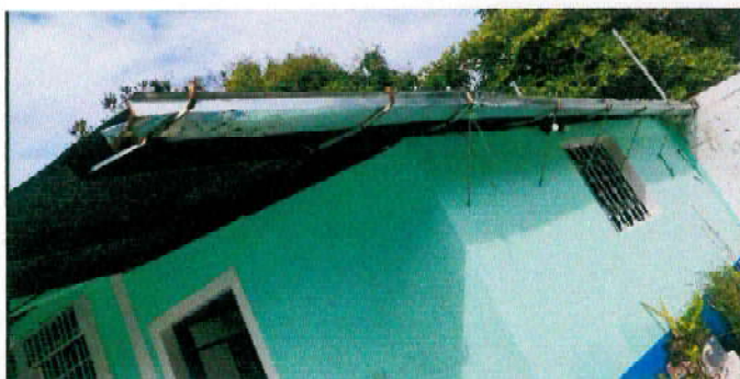
Foto 5: Sustitución de canal de metal, pescantes y caída de agua pluvial. Aula módulo 1
