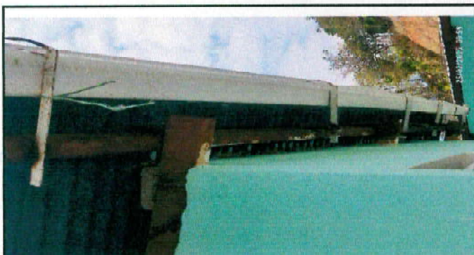
Foto 3: Sustitución de canal de pvc, por metal, y pescantes, en cocina
