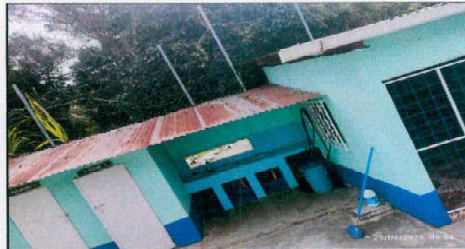
Foto 4: Sustitución de lámina, por lámina troquelada aluzinc calibre 26 de 8 pies, baño
