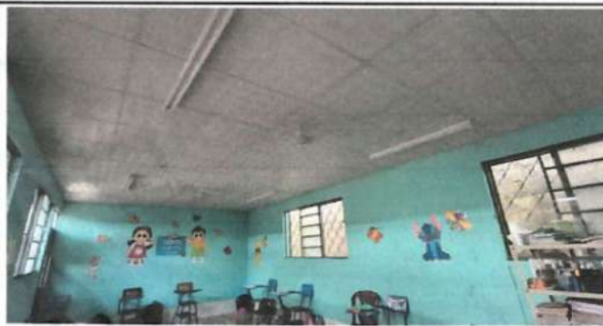
Foto 3: Sustrucción de cielo falso reticulando en aulas y dirección
