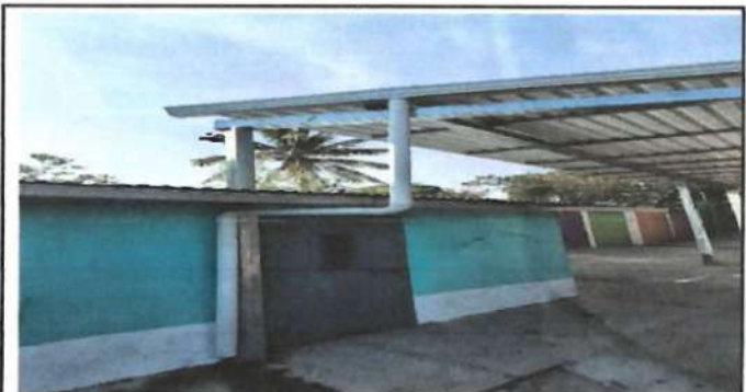
Foto 4: Suministro e instalación de canal de pvc
