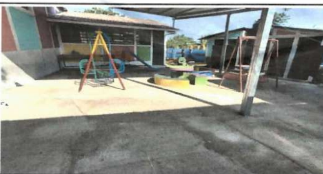
Foto 5: Sustrucción de piso de torta de concreto (grosor de 10 cms)
