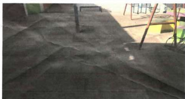
Foto 5: Sustitución de piso de torta de concreto (grosor de 10 cms )
