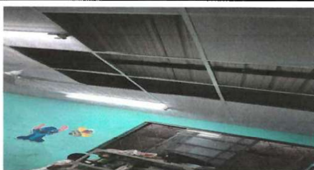
Foto 3: Sustitución de cielo falso reticulando en aulas y dirección
