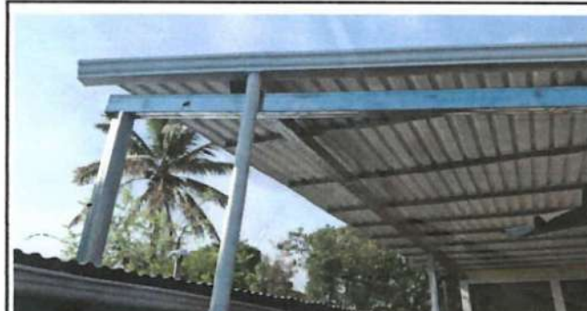
Foto 4: Suministro e instalación de canal de pvc
