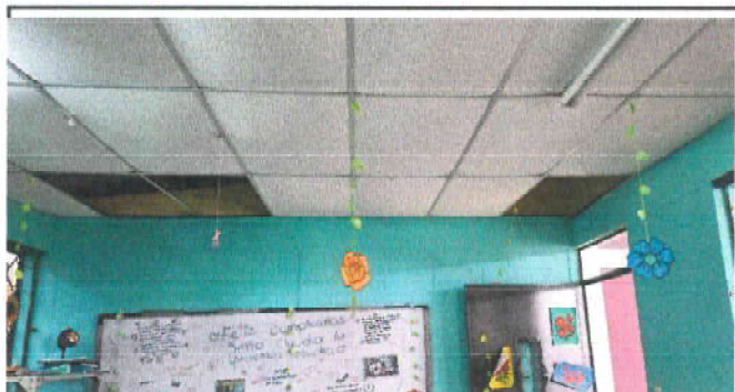
Foto 3: Sustrución de cielo falso reticulando en aulas y dirección
