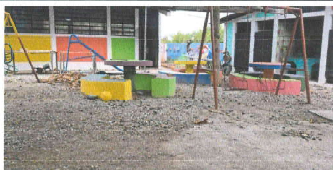
Foto 5: Sustrución de piso de torta de concreto (grosor de 10 cms )
