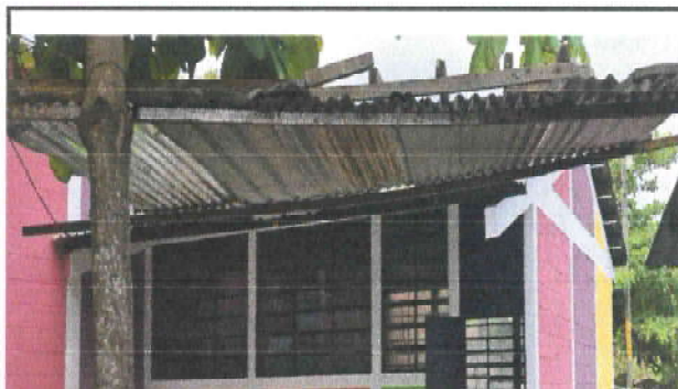
Foto 4: Suministro e instalacion de canal de pvc
