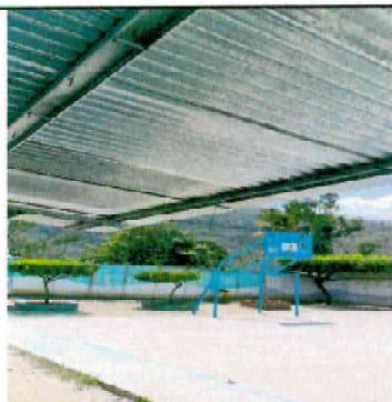
Foto 03: Sustitución de estructura y cubierta de lámina
