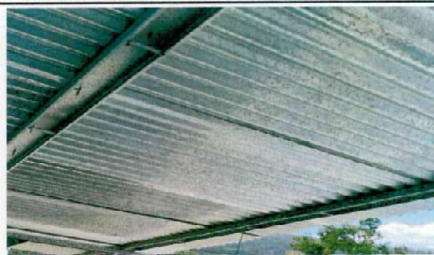
Foto 04: Sustitución de estructura y cubierta de lámina
