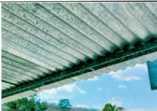
Foto 01: Sustitución y ampliación de cubierta de lamina
