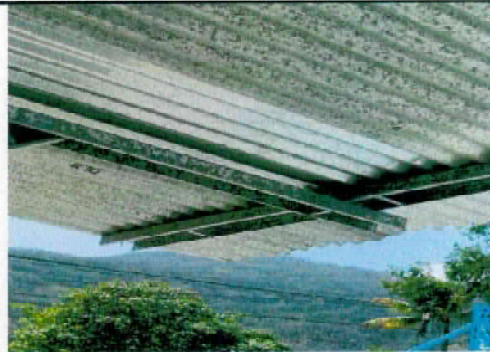
Foto 02: Sustitución y ampliación de estructura de techo
