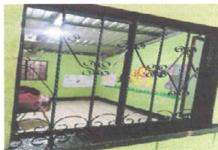
Foto 8: Sustitución de balcones de metal
