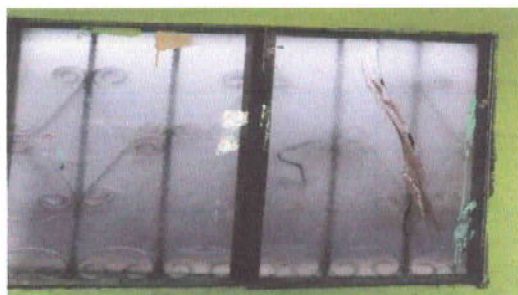
Foto 7: Sustitución de estructuras de metal de ventana por PVC
