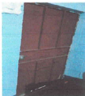
Foto 3: Sustitución de puertas de metal
