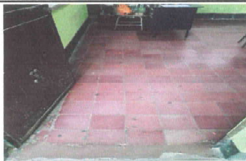
Foto 2: Sustitución de piso de cemento liquido por ceramico
