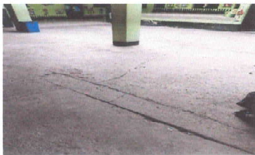
Foto 1: Reparación de piso de torta de cemento
