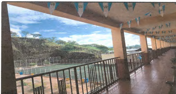
Foto 4: Ajuste de barandas hasta el techo, en el tercer nivel para la seguridad de los estudiantes.
