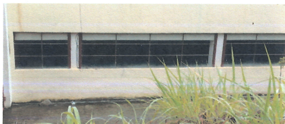
Foto1: SUSTITUCION DE VENTANA POR VENTANA CORREDIZA DE METAL (Segundo basico seccion B)
