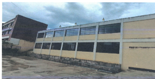
Foto 4: SUMINISTRO DE INSTALACION DE BALCONES DE METAL
