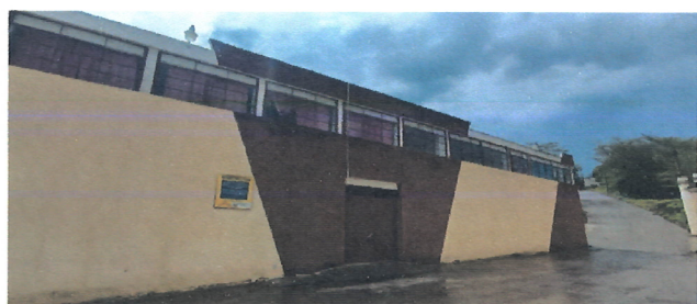
Foto 3: SUMINISTRO DE INSTALACION DE BALCONES DE METAL
