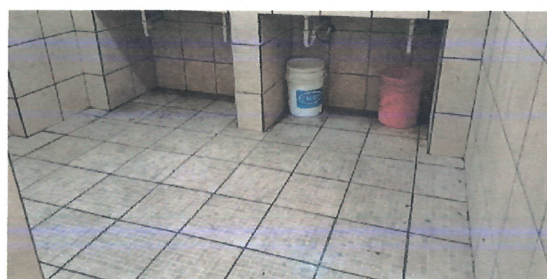
Foto 6: SUSTITUCION DE PISO CERAMICO SANITARIOS HOMBRES
