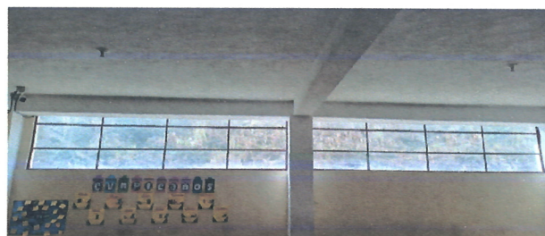
Foto 2: SUSTITUCION DE VENTANA POR VENTANA CORREDIZA DE METAL (Tercero Basico seccion A)
