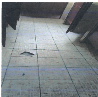
Foto 5: SUSTITUCION DE PISO CERAMICO SANITARIOS MUJERES
