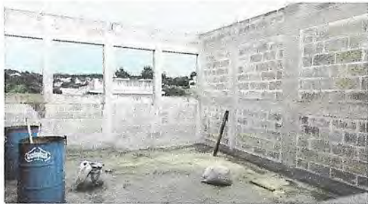
Foto 3: Instalación piso cerámico de 33x33 cm en 5 salones de 5.60 x7.15 m, un salón de 5.60 x 7.30m, un salón de 7m x 9.70m .
