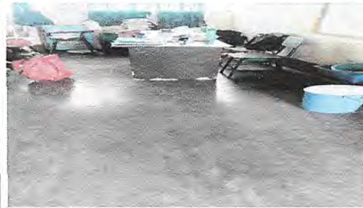
Foto 2: Instalación piso cerámico de 33x33 cm en 5 salones de 5.60 x7.15 m, un salón de 5.60 x 7.30m, un salón de 7m x 9.70m .
