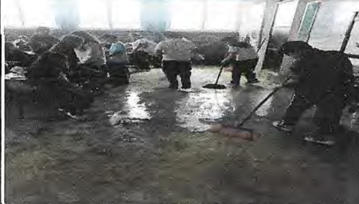
Foto 4: Instalación piso cerámico de 33x33 cm en 5 salones de 5.60 x7.15 m, un salón de 5.60 x 7.30m, un salón de 7m x 9.70m .
