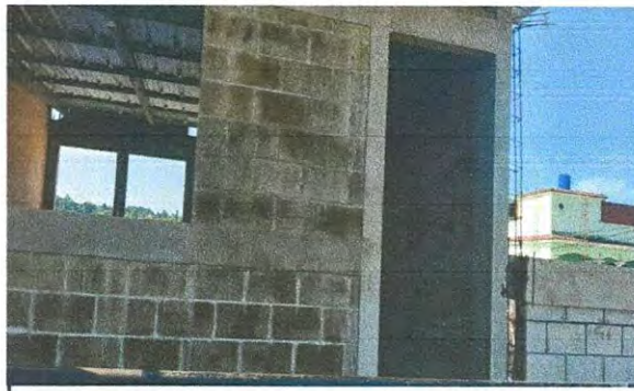
PUERTAS DE METAL: Instalación de puerta en aula existente.
