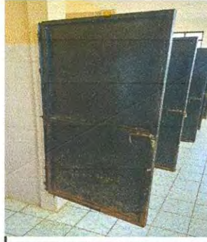
Mantenimiento estructura de puertas en sanitarios de 1.50 X0.66 (Lijado, sepillado y aplicación de pinutra )
