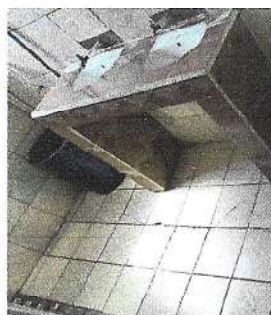
Foto 3: SERVICIOS SANITARIOS NIÑOS Y NIÑAS (En los servicios sanitarios de niñas y niños se realizaron lavamanos de concreto reforzado, con revesitimiento de porcelanato, se unificara los lavamanos.)
