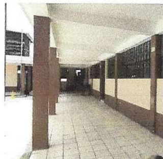
Foto 1: PISO Y CONTRAPISO (Instalación de piso cerámico 132.00m 2 , áreas de colocación: pasillo principal y s.s de niños y niñas - En el área del pasillo se colcara sobre el piso existente.)
