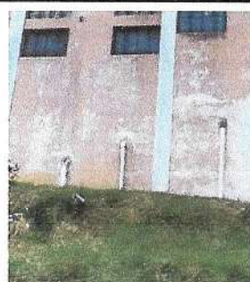
Foto 5: REPARACIÓN DE RED DE DRENAJE Y RED DE AGUA POTABLE (Sustitución de tubería de drenaje sanitario y pluvial, fundición de concreto para protección de tubería expuesta en la parte posterior)
