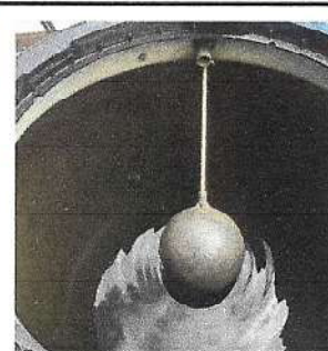
Foto 6: REPARACIÓN DE RED DE DRENAJE Y RED DE AGUA POTABLE (Sustitución de flotador de cisternas.)
