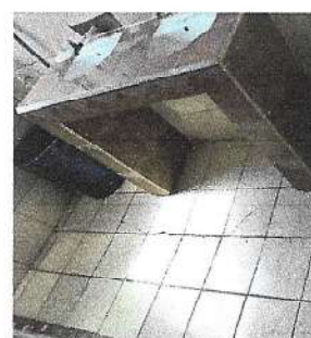
Foto 2: PISO Y CONTRAPISO (Compactación y fundición de contrapiso en las áreas donde presenta hundimiento s.s. niñas y pasillo conector con s.s. maestros. El espesor del contrapiso 0.10M)
