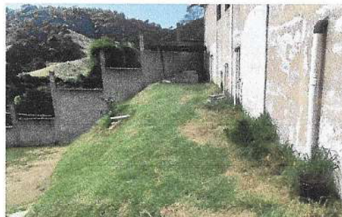
Foto 4: BANQUETA (Fundición de banqueta 14.85 m x 1.20m espesor 0.15m, se realizara en la parte posterior de la escuela para evitar la humedad en esa área.)
