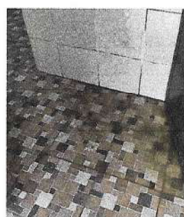
Foto 2: PISO Y CONTRAPISO (Compactación y fundición de contrapiso en las áreas donde presenta hundimiento s.s. niñas y pasillo conector con s.s. maestros. El espesor del contrapiso 0.10M)
