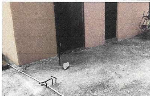
Foto7: CERCO o MURO PERIMETRAL (Cerca para delimitación en el área de cocina 15.5 metros lineales, altura 1.60 m. Se realizara cerco de malla galvanizada con tubería cuadrada 1 1/2 chapa 16 - más puerta)
