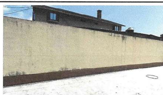
Foto 12: PINTURA. (Pintura general en áreas de salones, servicios sanitarios y muro perimetral, Se aplicara 750 m2 de pintura a dos capas, por deterioro de pintura, se aplicara resanes en las partes necesarias.)
