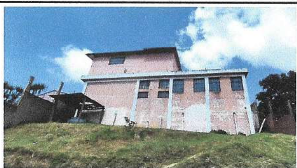
Foto 11: PINTURA. (Pintura general en áreas de salones, servicios sanitarios y muro perimetral, Se aplicara 750 m2 de pintura a dos capas, por deterioro de pintura, se aplicara resanes en las partes necesarias)
