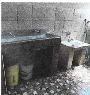
Foto 3: SERVICIOS SANITARIOS NIÑOS Y NIÑAS (En los servicios sanitarios de niñas y niños se realizaron lavamanos de concreto reforzado, con revesitimiento de porcelanato, se unificara los lavamanos.)
