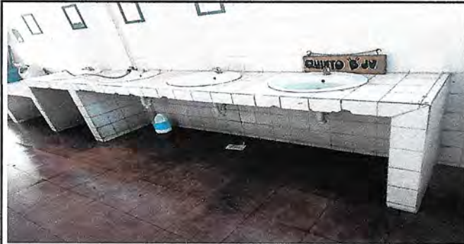
Foto 1: Sustrucción de azulejo y piso en area de baños de niñas y niños.
