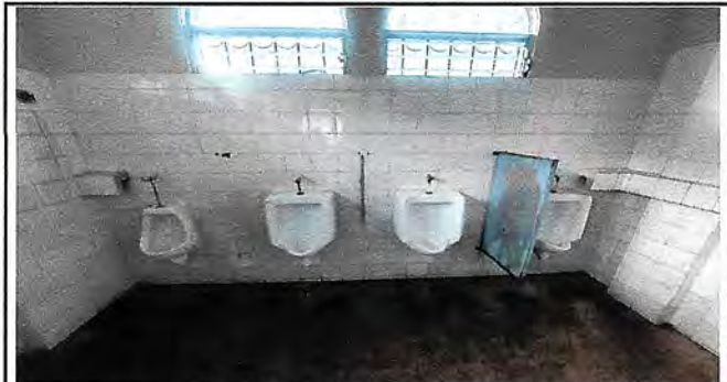
Foto 2: Sustrucción de azulejo y piso en area de baños de niños, y unidades de servicios sanitarios.
