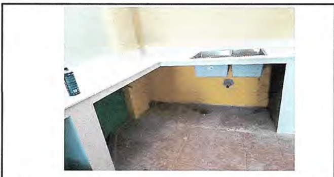
Foto 4: Sustrucción de piso en area de cocina e instalación de puertas de mueble de cocina en cocina.
