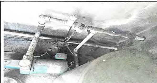
Foto 3: Mantenimiento de bomba existente, e instalación de nueva bomba para uso en area de cocina.
