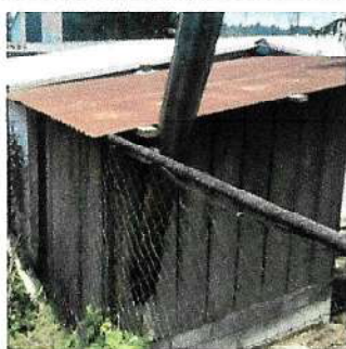
Foto 1: Sustrucción de 3 paredes de madera, por paredes de block en cocina. Paredes laterales 2.00m, pared frontal 2.85m con un alto de 3.08m total 21.m2
