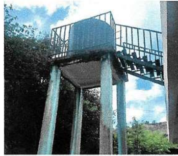
Foto 4: Area donde se va a sustituir el tinaco.
