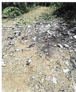
Foto 3: Area de pozo manualmente a una profundidad de 26.00 mts, se colocaran tubos de concreto Perforados de 36 pulgadas para encamisar el pozo, esto para evitar desmoronamiento.
