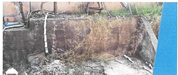
Foto 4: El muro presenta undimientos en los escalones, se tiene planificado quitar lo dañado, compactar y fundir una capa de 6cm. Asimismo, se le aplicará un repello gris a todo el muro.
