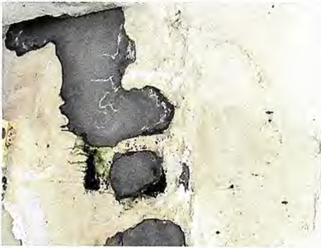
Foto 3: REPARACIÓN DE FUGA DE SANITARIOS: Se realizará el cambio de tubería
