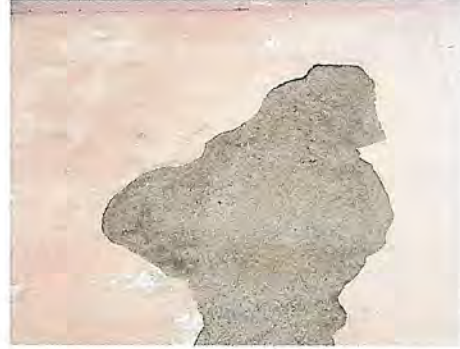
Foto 2: RESANAMIENTO DE REPELLO: Reparación/sustitución de repello de paredes deterioradas por humedad y hongo, se aplicará material nuevo
