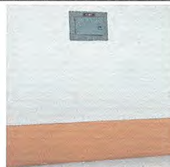
Foto 6: Reparacion del sistema electrico
