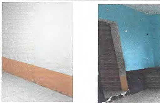
Foto 5:Pintura en interiores y exteriores
