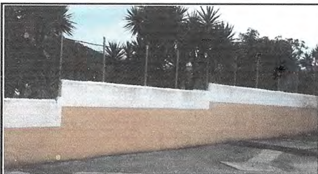
Foto 3:Cerco o muro perimetral
