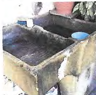
FOTO 2: Sustitución de pila existente por pileta de concreto 1.50 cm de largo*80 cm de ancho*85 cm de alto
