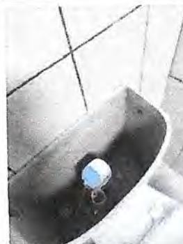
FOTO 4: Cambio de inodoro deteriorados por uso
