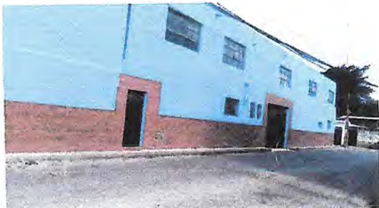
FOTO 1: Apertura de vano en muro existente, retiro y manejo de escombros, conformación del vano y colocación de ventana de PVC con herrajes completos.
