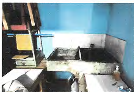
Foto 3: Fabricación de pila
