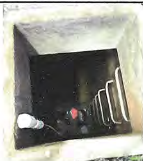
Foto 5: Reparación de sistema
