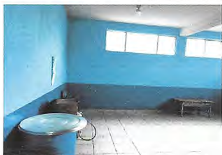
Foto1: Sustitución de muebles de cocina y pintura para piso antideslizante.
