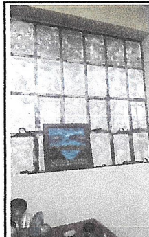
Foto 4: Sustitución de vidrios en diferentes áreas
