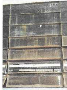
Foto 2: En la foto se puede observar lo dañado que se encuentran los marcos de las ventanas y los vidrios.
