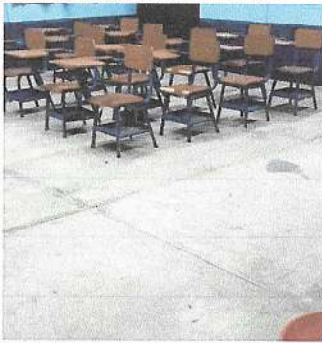
Foto 3: Se debe sustituir la torta de cemento existente por piso cerámico en tres aulas.
