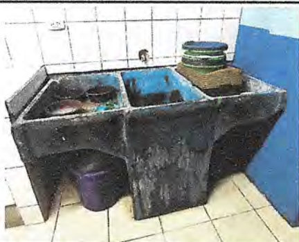
Foto1: SUSTITUCIÓN DE PILA POR PILETA DE CONCRETO
