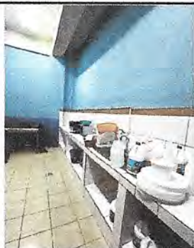
Foto 3: RE INSTALACIÓN CORRECTAMENTE DE TUBERIA DE AGUA POTABLE
