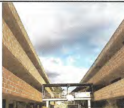
Foto 2: Mantenimiento y pintura a las dos fachadas del establecimiento
