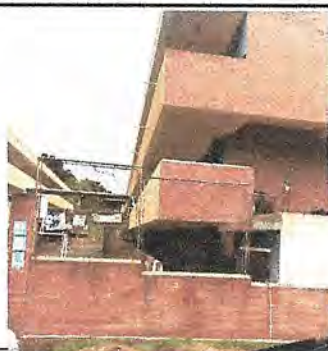
Foto 5: Sustitución de maya por pared de block.
