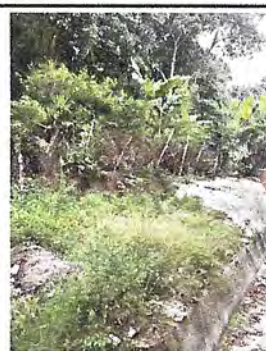
Foto 4: SUSTITUCIÓN DE CERCO DE ALAMBRE POR MAYA
