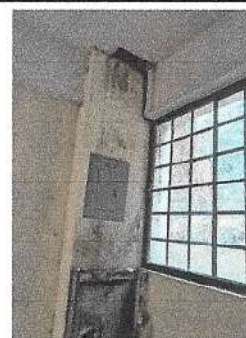
Foto 7 y 8: REPARACIÓN DE SISTEMA ELÉCTRICO (Se realizara la sustitución de piezas de tablayeso en mal estado de ducto electrico, de 4*1 metros, los 3 niveles, sustitucion de accesorios electricos de iluminacion).
