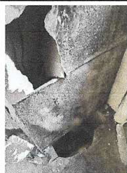
Foto 7 y 8: REPARACIÓN DE SISTEMA ELÉCTRICO (Se realizara la sustitución de piezas de tablayeso en mal estado de ducto electrico, de 4*1 metros, los 3 niveles, sustitucion de accesorios electricos de iluminacion).
