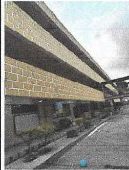
Foto 11 y 12: PINTURA EN MUROS INTERIOR Y EXTERIOR (Limpieza de paredes, lavado y aplicacion de y pintura a dos manos en interiores de salones, 1250.00m2 + 1389.00 m2; de pintado de paredes exteriores de fachada y pasillos.)
