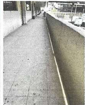
Foto 11 y 12: PINTURA EN MUROS INTERIOR Y EXTERIOR (Limpieza de paredes, lavado y aplicacion de y pintura a dos manos en interiores de salones, 1250.00m2 + 1389.00 m2; de pintado de paredes exteriores de fachada y pasillos.)
