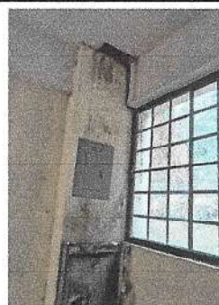
Foto 7 y 8: REPARACIÓN DE SISTEMA ELÉCTRICO (Se realizara la sustitución de piezas de tablayeso en mal estado de ducto electrico, de 4*1 metros, los 3 niveles, sustitucion de accesorios electricos de iluminacion).
