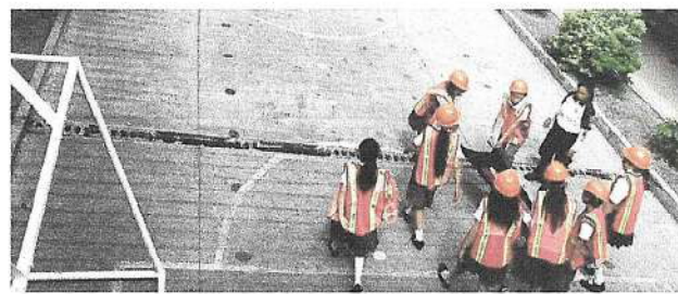
Foto 4: Mantenimiento de cuneta, sustitucion y colocación de rejillas en cunetas ubicadas en el patio del establecimiento, una longitud de 15.65x0.40 mts. Rejilla de metal con angular de 1"x1"x1/4" + hierro plano de 1"x1/4" separados a cada 0.04 centímetros.
