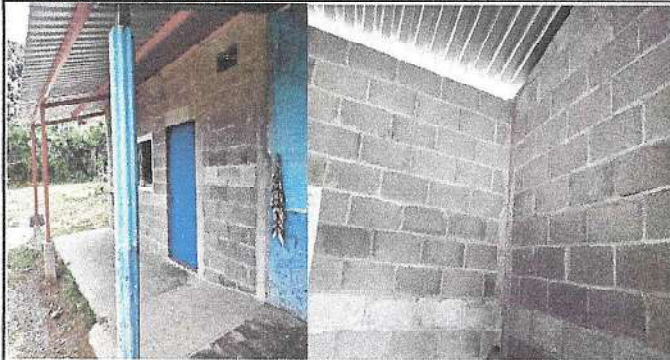
Foto 1: REPARACION DE AREA DE COCINA (Aplicación de acabado gris y blanco en todo el modulo de la cocina, interior y exterior).
