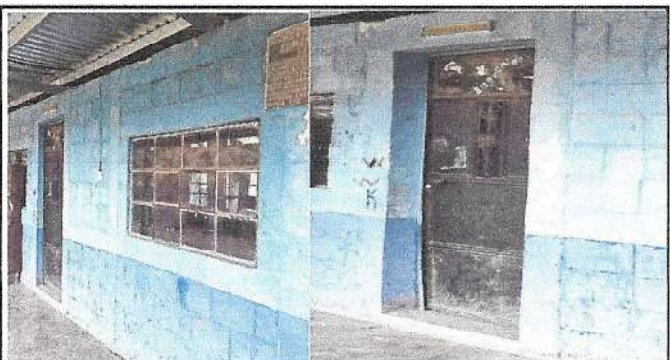
Foto 4: Sustitución de puertas de metal con medidas de 0.90mt de ancho por 2.15mt de alto, fabricadas con tubo cuadrado de 1", angular de 1/2", plana de 3/16, chapa 16; lámina de 1/16; chapa yale; pintada con una mano de fondo gris y dos manos de pintura anticorrosiva azul, Sherwin Williams.
