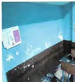
Foto1: CERNIDO EN MUROS DETERIORADOS
