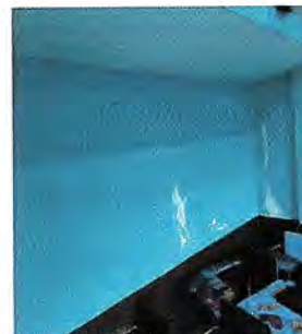
Foto 4: APLICACIÓN DE 350.00 DE PINTURA EN LAS AREAS DETERIORADAS
