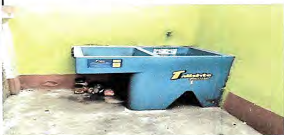
Foto 7 REPARACION DE DRENAJE DE LA PILA
