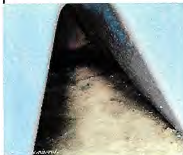
Foto 8 REPARACION DE DRENAJE HACIA LA PILA
