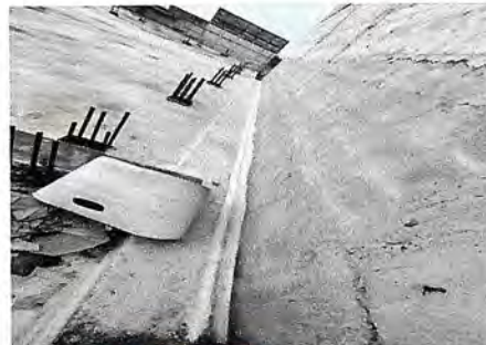
Foto 2: IMPERMIABILIZACION DE LOZA TERCER NIVEL
