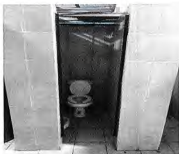
Foto 3: SUSTITUCION DE DOS SANITARIOS Y ACCESORIOS EN BAÑO DE MUJERES
