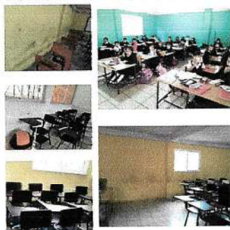
Foto 6: PINTURA PAREDES EN AULAS SEGUNDO NIVEL
