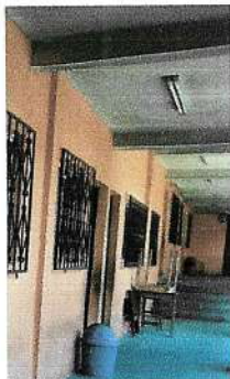
Foto 3: PINTURA TECHO CORREDORES PRIMER NIVEL
