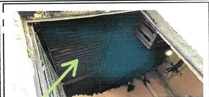
Foto1: SUSTITUCIÓN DE LAMINA EN COCINA
