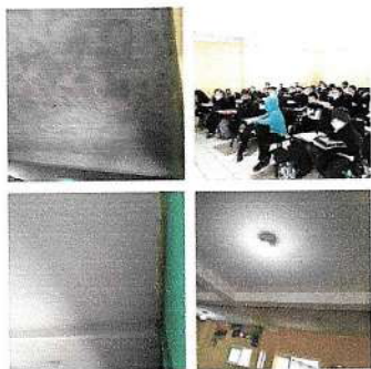
Foto 3: PINTURA TECHOS PRIMER NIVEL AULAS
