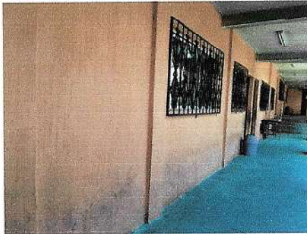
Foto 1: PINTURA PAREDES CORREDORES PRIMER NIVEL
