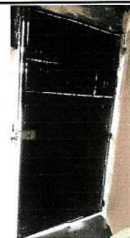
Foto 6: SUSTITUCIÓN DE PUERTA DE COCINA
