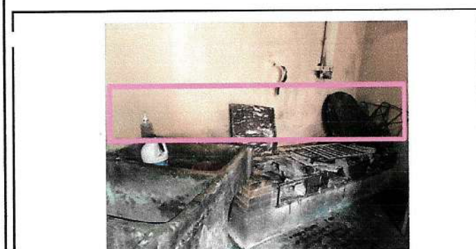
Foto 5: INSTALACIÓN DE AZULEJO EN PARED
