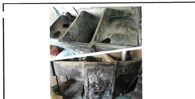
Foto 6: INSTALACIÓN DE AZULEJO EN PILAS
