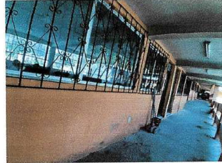
Foto 2: PINTURA PAREDES CORREDORES SEGUNDO NIVEL
