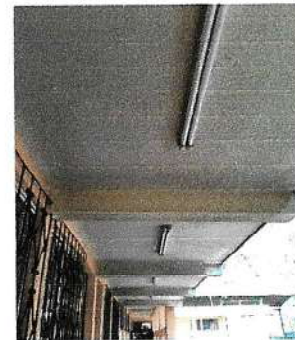
Foto 4: PINTURA TECHO CORREDORES SEGUNDO NIVEL
