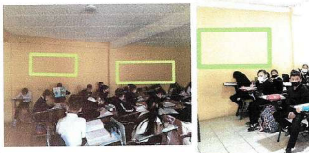
Foto 2: INSTALACIÓN DE 3 VENTANAS PVC
