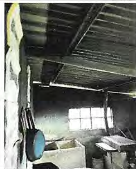
Foto 2: Mejoramiento de area de cocina, colocacion de azulejo, piso, nueva cocina de leña y pila exterior.
