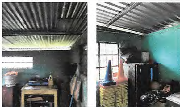
Foto 1: Mejoramiento de area de cocina, sustitucion de estructura.
