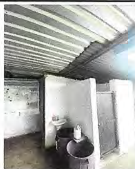
Foto 4: Sustitucion de extructura y cubierta en area de corredor.
