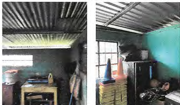
Foto 1: Mejoramiento de area de cocina, sustitucion de estructura.
