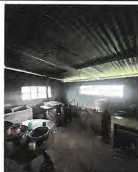
Foto 6: Complutado de altura de paredes de cocina.
