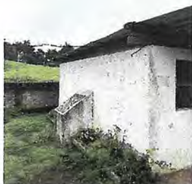
Foto 5: Completado de altura de paredes que hace falta.
