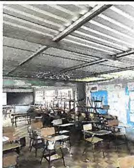
Foto 3: Sustitucion de estructura metalica y lamina en area de salones.
