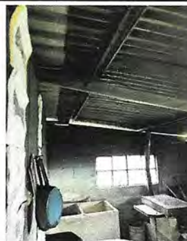
Foto 2: Mejoramiento de area de cocina, colocacion de azulejo, piso, nueva cocina de leña y pila exterior.
