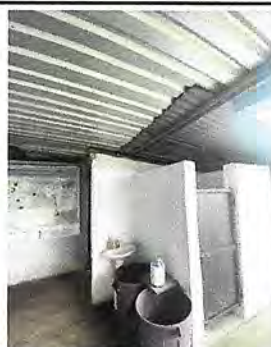
Foto 4: Sustitucion de extructura y cubierta en area de corredor.
