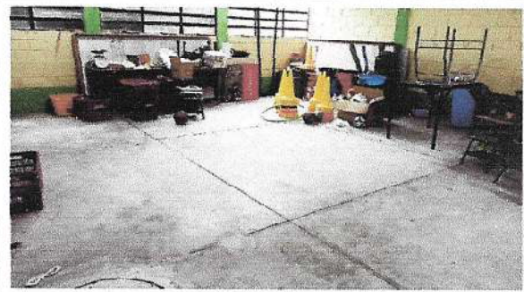
Foto 2: sustitución de torta de cemento por piso cerámico en 3 aulas, de 7.30 m por 7.81 metros haciendo un total de 171.00 metros cuadrados de piso cerámico
