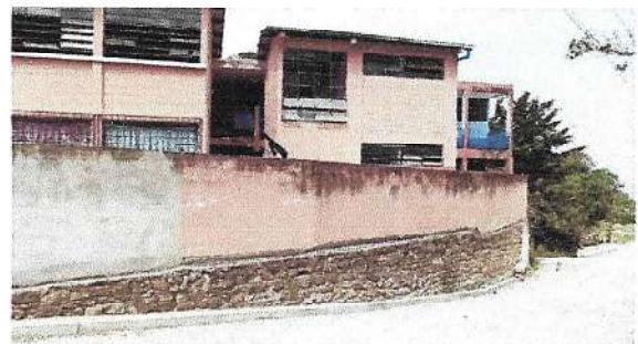
Foto 4: Instalación de malla , 40.00x 2.40 mts. lineales, con un total de 96.00 m2 de Electromalla con tubo cuadrado a cada 2.50 mts de separación, sobre base de muro perimetral existente).
