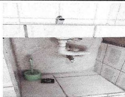
Foto 6: sustitución accesorios de lavamanos)
