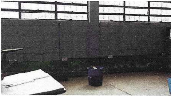
Foto 1: aplicación de dos manos de pintura en 407.50 metros de pintura dentro y fuera de aulas con zócalo de 0.80 siendo 213.41 metros cuadrados
