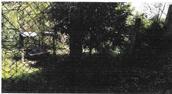
Foto 3: Sustitución de cerca de malla e instalación de 33.00x 2.40 mts. lineales, con un total de 79.20 m2 de Electromalla con tubo cuadrado a cada 2.50 mts de separación, sobre base de muro perimetral existente, do la parte trasera de la escuela, colocación de 5 hiladas de block sobre muro existente, no se incluye fundición de cimientos ni columnas)
