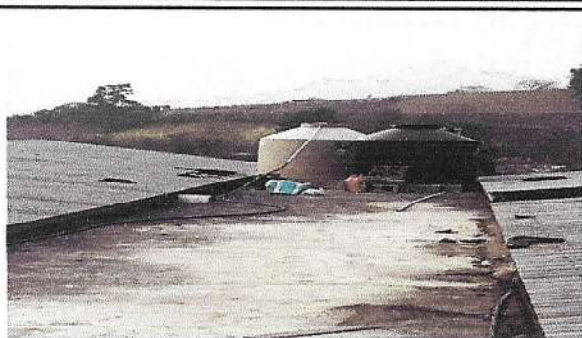
Foto 7: Instalación de tubería nueva, desde acometida a tinaco nuevo y de tinaco hacia área de cocina (uno de los tinacos es prestado)
