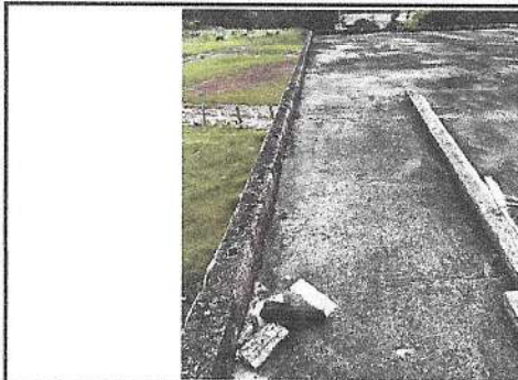
Foto 3: Deterioro de mezcón existente por los años de construcción y por lo tanto hay filtración de humedad en algunas partes de la losa.
