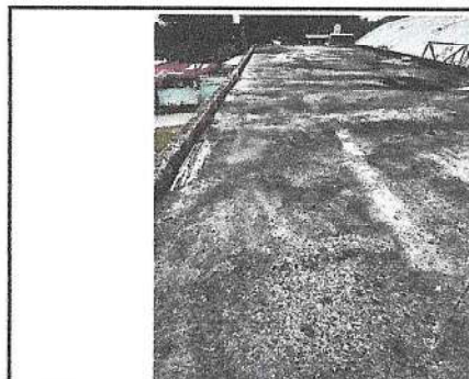
Foto 4: Deterioro de mezcón existente por los años de construcción y por lo tanto hay filtración de humedad en algunas partes de la losa.
