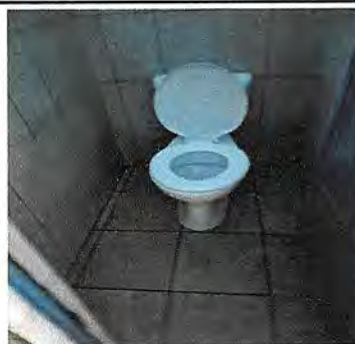
Foto 2: SERVICIOS SANITARIOS Y ACCESORIOS (Se realizará el cambio de 1 inodoro y cambio de accesorios en el inodoro ,en el lavamanos del sanitario y se colocará un nuevo sifón en el sanitario de maestros.)
