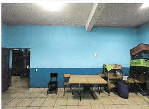
FOTO 3 REPARACIÓN DE COCINA (Mesa de concreto con divisiones con medidas de 4.30 metros de largo x 0.75 cms de fondo x 0.90 cms de alto con puertas de metal de 0,80 x 0.90 metros cada una , incluye pasadores
