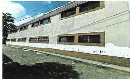
Foto 4: PINTURA EN MUROS EXTERIOR: (Limpieza de paredes, lavado y aplicación de pintura a dos manos. )
