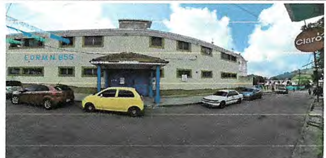
Foto 6: PINTURA EN MUROS EXTERIOR.
