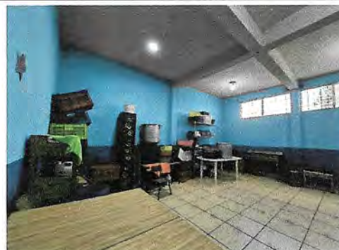
Foto 4: REPARACIÓN DE COCINA (Gabinete de concreto con medidas 1.90 x 1.20 x .60 metros en área de cocina)
