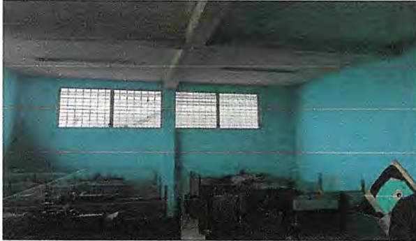
Foto1: REPARACIÓN DE SISTEMA ELÉCTRICO: (Se hará la instalación del sistema eléctrico para cada una de las computadores del salón de computación, Cambio de tomacorrientes y revisión de red eléctrica. )
