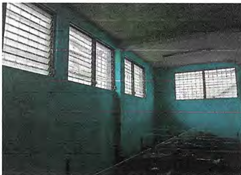
Foto 3: REPARACIÓN DE SISTEMA ELÉCTRICO.
