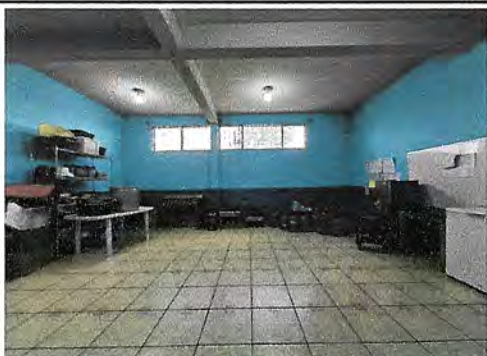
Foto 5: REPARACIÓN DE COCINA (Pila fundida de dos lavadoras corectivo de agua con medidas de 2.40x90x80 metros)
