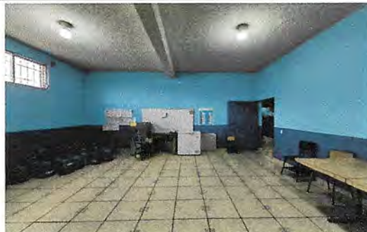
Foto 2: REPARACIÓN DE DRENAJES Y RED DE AGUA POTABLE (Se realizará apertura y conexión de drenaje para instalación de una pila que se hará de acuerdo a un tamaño establecido y también la instalación de un chorro.)
