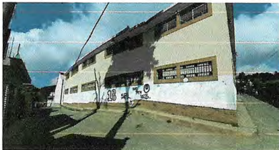
Foto 5: PINTURA EN MUROS EXTERIOR.
