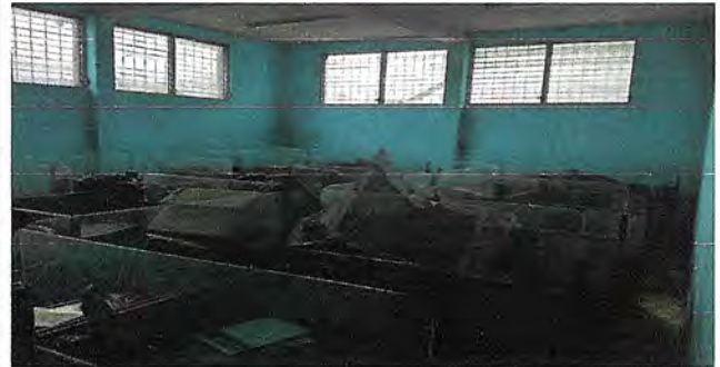
Foto2: REPARACIÓN DE SISTEMA ELÉCTRICO.
