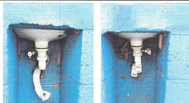
Foto 4: REPARACIÓN LAVAMANOS. (Sustitución de drenaje tipo cifón, ajuste de grifo en 3 lavamanos.)
