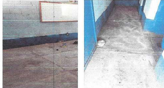
Foto 2: PISO. (Instalación de piso cerámico 203m2, áreas de colocación: aulas, cocina, servicios sanitarios, en el área de servicio sanitario se instalará piso antideslizante. Las áreas descritas no tienen piso cerámico.)
