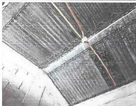
Foto 1: REMPLAZO DE FOCOS. (Sustitución de focos en pasillo y cocina, por deterioro.)
