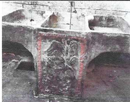
Foto 2: REMPLAZO DE PILA. (Sustitución pila de 2 lavaderos. Cambio de pila por deterioro de la existente.)
