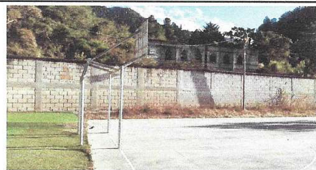
Foto 5: PINTURA. (áreas de salones, cocina, servicios sanitarios y muro perimetral, puertas metálicas, porton y porterías. Se aplicará 1115 m2 de pintura a dos capas, por deterioro de pintura en las áreas descritas.)
