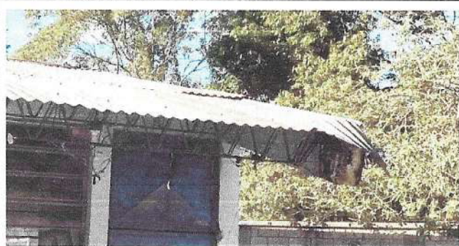
Foto 3: CUBIERTA DE LAMINA. (Sustitución de 10 láminas de 10 pies, sustitución de capo de 8 pies, reparación general por goteras, se aplicará sellador asfáltico y tela de refuerzo.)
