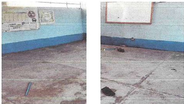
Foto 1: PISO. (Instalación de piso cerámico 203m2, áreas de colocación: aulas, cocina, servicios sanitarios, en el área de servicio sanitario se instalará piso antideslizante. Las áreas descritas no tienen piso cerámico.)
