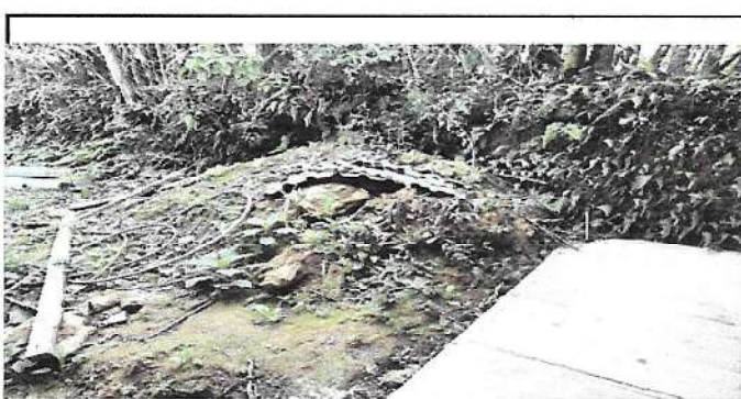
INSTALACION DE BASE PARA TINACO
