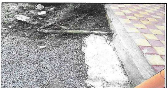
CUNETAS DE CONCRETO
