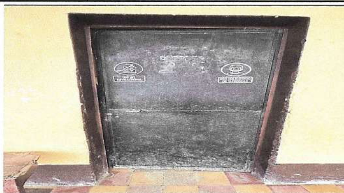
Mantenimiento de Puertas en Area de salones
