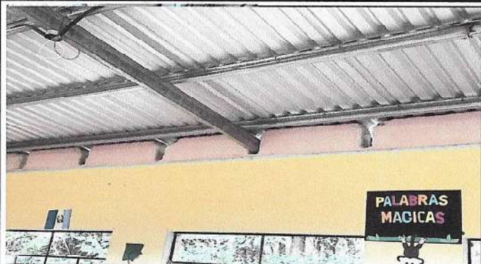
INTALACION DE CIELO DE PVC
