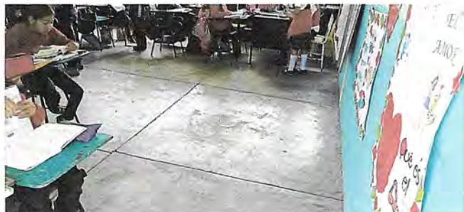
Foto1:PISO (Instalación de piso cerámico 206m2, se instalara en 4 aulas de 7.20x7.02m, las 4 aulas representan las mismas dimensiones, cada una de ellas carece de piso.)
