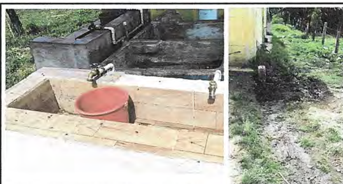
Foto10: SERVICIOS SANITARIOS Y SUS ACCESORIOS (Reparación de lavamanos, reparación piso de concreto, instalación de accesorios, sustitución de llave de paso en tubería central)
