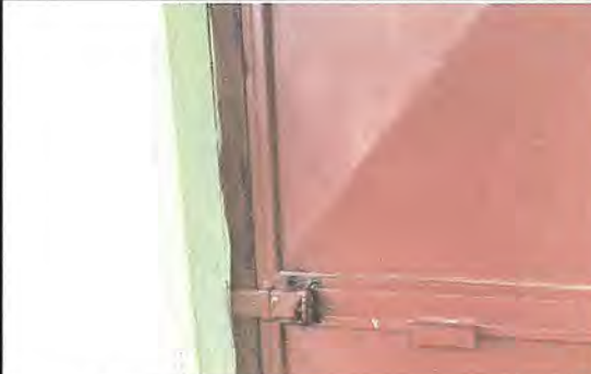
Foto 12: PUERTA (Instalación de chapa izquierda en puerta metalica, falta de la misma en dicha puerta)
