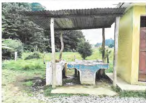
Foto11: SERVICIOS SANITARIOS Y SUS ACCESORIOS (Reparación de lavamanos, reparación piso de concreto, instalación de accesorios, sustitución de llave de paso en tubería central)
