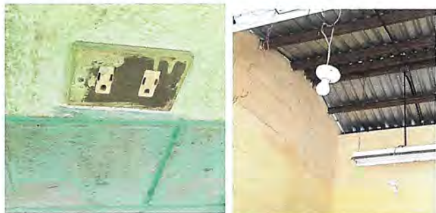
Foto 7: REPARACIÓN DE SISTEMA ELECTRICO ( Sustitución de 39 tubos led de 18watts led y reubicación de 13 lamparas tubulares fluorescentes, revisión al sistema de interruptores, cambio de dos tomacorrientes .)
