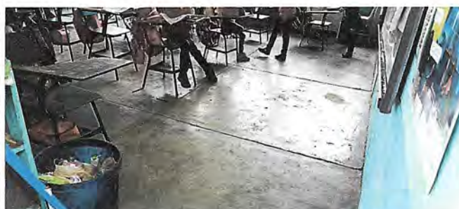
Foto2:PISO (Instalación de piso cerámico 206m2, se instalara en 4 aulas de 7.20x7.02m, las 4 aulas representan las mismas dimensiones, cada una de ellas carece de piso.)
