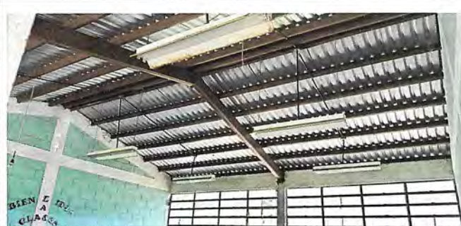
Foto 6:REPARACIÓN DE SISTEMA ELECTRICO (Sustitución de 39 tubos led de 18watts led y reubicación de 13 lamparas tubulares fluorescentes, revisión al sistema de interruptores, cambio de dos tomacorrientes.)
