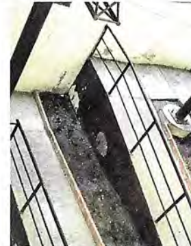
Foto 2: RESANA-MIENTO DE REPELLO: Reparación/sustitución de repello de paredes deterioradas por humedad y hongo, se aplicara material nuevo Resana-miento de 100 metros de repello
