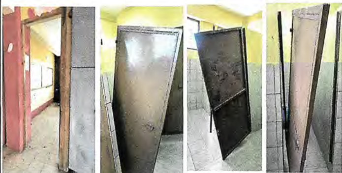
Foto 9: PUERTA Y REPARACIÓN DE PUERTAS: Instalación de puerta de metal en aula y reparación de puertas en sanitarios de niños y niñas
