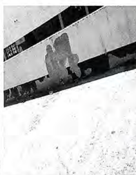
Foto 2: RESANA-MIENTO DE REPELLO: Reparación/sustitución de repello de paredes deterioradas por humedad y hongo, se aplicara material nuevo Resana-miento de 100 metros de repello
