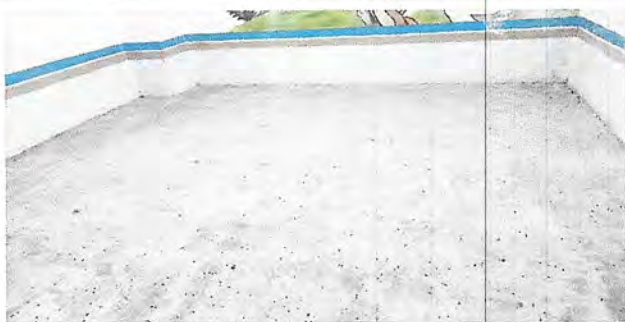
Foto 3: Sustitución de torta de cemento por piso en aula
