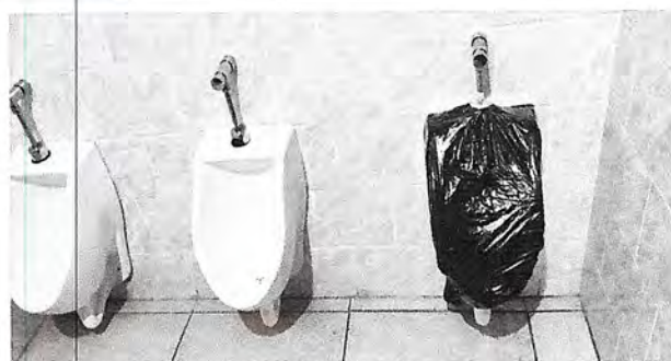
Foto 4: Mantenimiento y reparacion de sanitarios y mingitorios.
