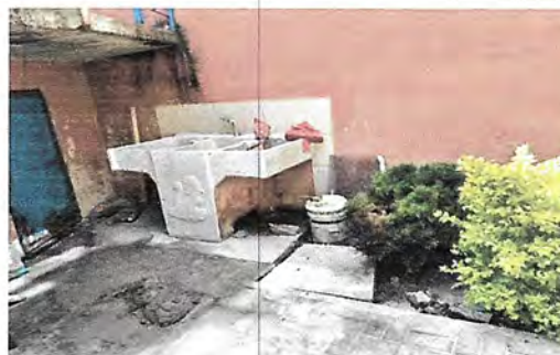
SUSTITUCION DE PILA Y REPARACION DE AREA DE CONCRETO
