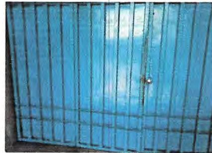
MANTENIMIENTO DE PORTON PRINCIPAL
