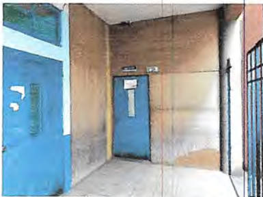
SUSTITUCION DE PARED DE PLYWOOD POR PARED DE BLOCK
