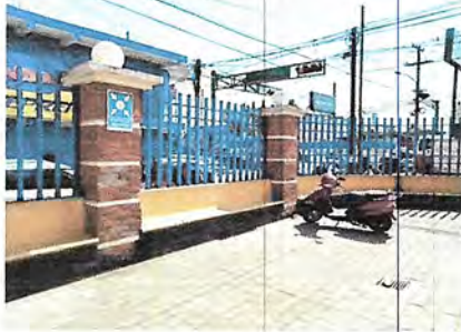
COLOCACION DE LAMINA ALREDEDOR DE LAS REJAS
