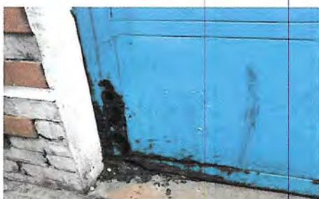
REPARACION Y MANTENIMIENTO DE PORTON AUXILIAR
