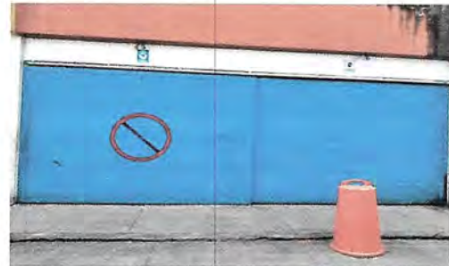
MANTENIMIENTO DE PORTONES TALLER DE MECANICA
