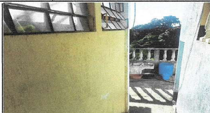
Foto2: sustitucion de cubierta de lamina y estructura de techo para el ingreso a la cocina
