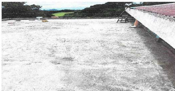
Foto6: sustitucion de impermeabilizacion de losa en mal estado
