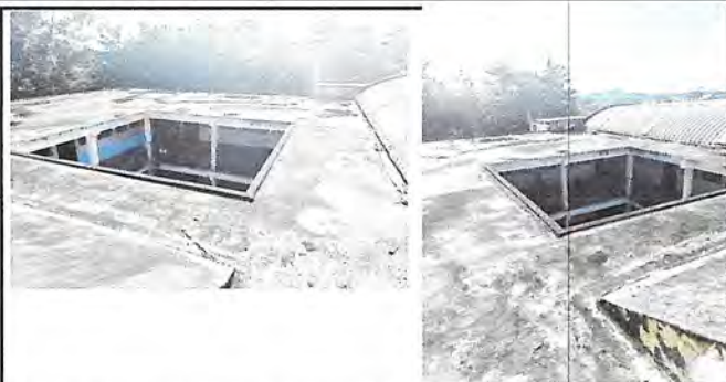
Foto 1: Impermeabilización, pañuelos, mantenimiento en bajadas de agua en área de terraza sobre patio de preprimaria
