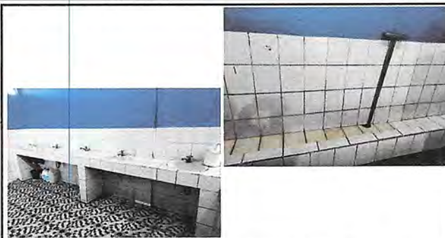
Foto 2: Remodelación de sanitarios de niños en el primer nivel, cambio de piso, azulejo, sanitarios, lavamanos y mingitorio, arreglo y ajuste de puertas
