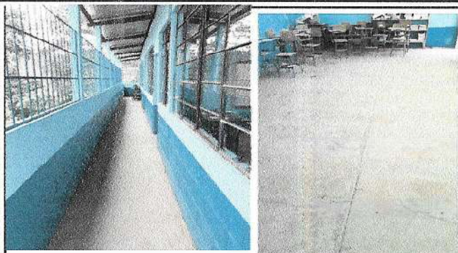
Foto1: Colocacion de Piso ceramico 305 M2
