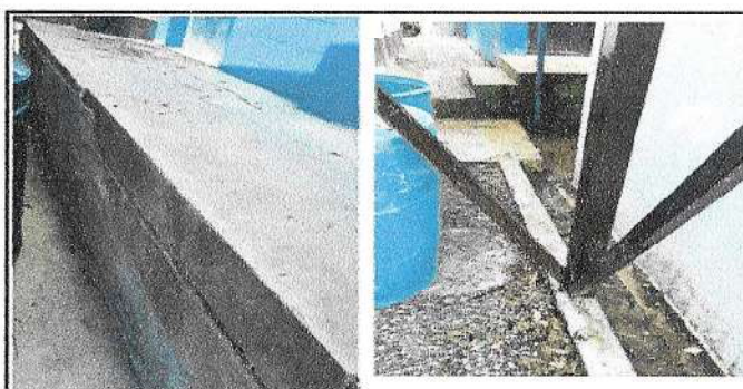
Foto 5: Reparación de banqueta, fundición de banqueta area de cocina.
