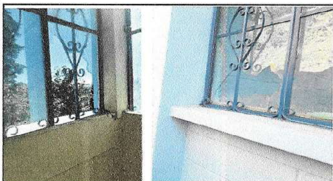
Foto 3: Sustitucion de vidrios quebrados de ventanas en primero y segundo nivel.
