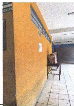
Foto 2: Se realizará el mantenimiento y pintado en muros exteriores e interiores del establecimiento
