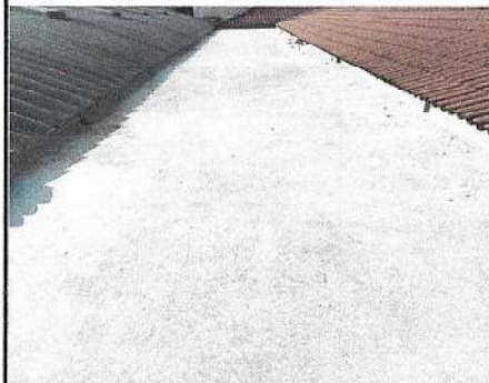
Foto 2: impermeabilizacion de techo
