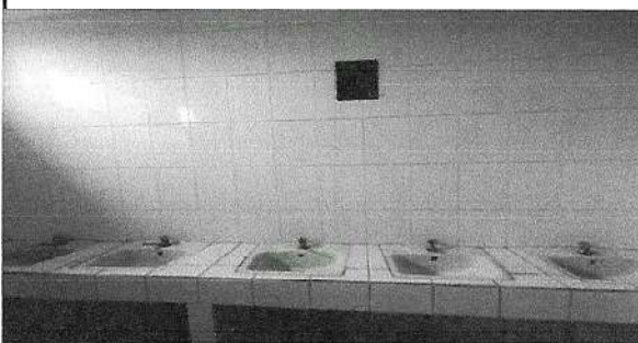
Foto 4: Cambio de llaves de agua de lavamanos de los baños de la parte alta de las niñas.
