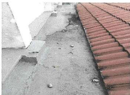
Foto1: Impermeabilizacion de techo
