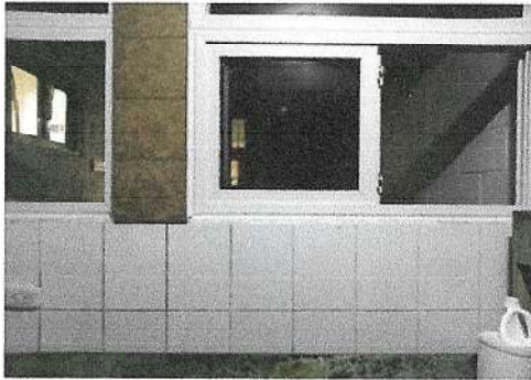
Foto 1: Demolición de la mitad de la pared para ampliación de cocina y fabricación de top de concreto y forrado con azulejo.
