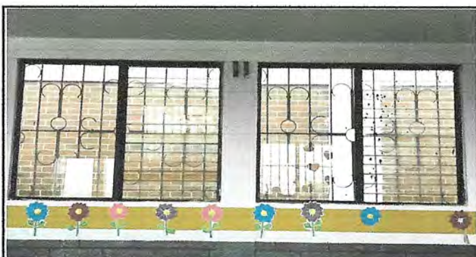
Foto 3: Sustitución de ventanas por ventanas de PVC a dos bandas corredizas a instalar en la dirección y aulas de tercero, cuarto y quinto / 2 por aula y 1 de la dirección
