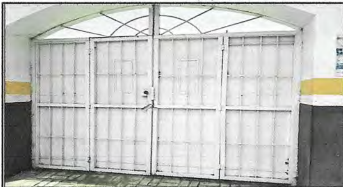
Foto 2: Sustitución e instalación de portón de ingreso principal del establecimiento
