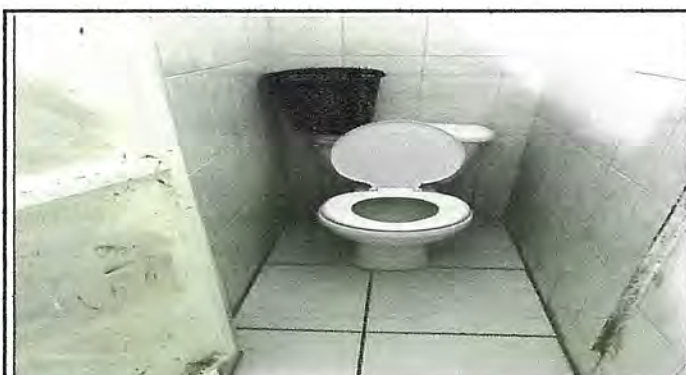
Foto 4: Sustitución de 6 sanitarios y sus accesorios
