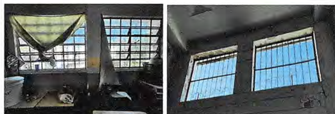
Foto 2: VENTANAS (Sustitución de 37 ventanas de metal a PVC en el segundo nivel del edificio incluyendo aulas y baño así como cocina y el aula de segundo "A" , con un total de 57.65 m2.)
