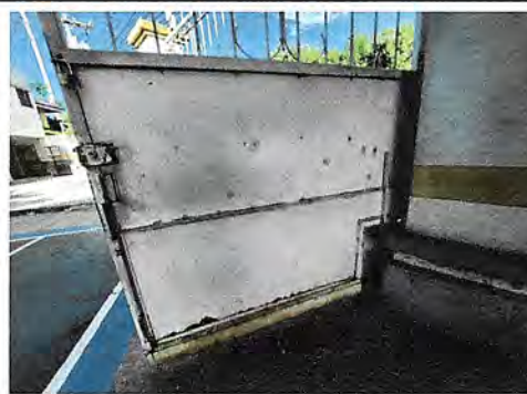
Foto 6: MANTENIMIENTO A PORTONES (Mantenimiento de portón principal por oxidación y remplazo de lamina parte inferior y retocado de pintura)
