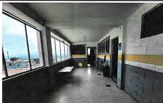
Foto 3: REPARACION DE SISTEMA ELECTRICO (Implementación de pared en área de pasillo para adecuar sistema eléctrico // implementar nuevas unidades de tomacorriente// en pared, nueva puerta para el resguardo de la
