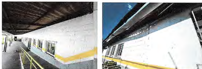
Foto1: REPARACIÓN DE REPELLO Y CERNIDO DE PAREDES (Se realizara demolición y resane de un ancho de 10 centímetros a lo largo de la pared para ventilación en las 3 aulas del área de primaria.)
