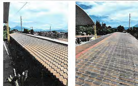
Foto 5: CUBIERTA DE LAMINA (Sustitución de laminas por 20 laminas tipo teja por filtración de agua y malas condiciones de la misma en el edificio de preprimaria.)
