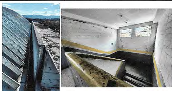
Foto 4: IMPERMEABILIZACION DE LOSA (Resanado de pared e impermeabilizante del techo, y limpieza de canal de concreto, mantenimiento a techo por filtración de agua e instalación de nuevo canal metálico.)
